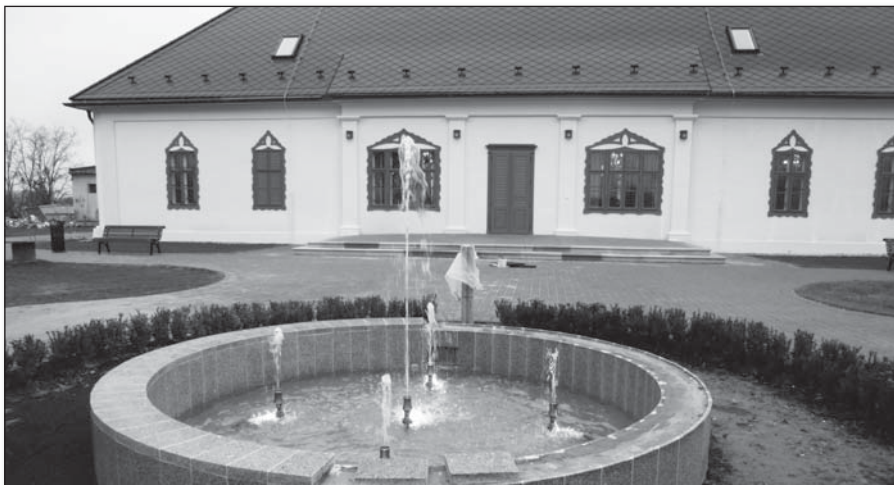
● Moderná fontána je príjemným doplnkom historickej budovy v areáli kúrie.
