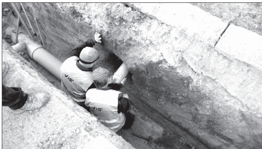
● V súčasnej etape prác na kanalizácii by malo byť do konca decembra 2016 dokončených dvanásť domových prípojk
