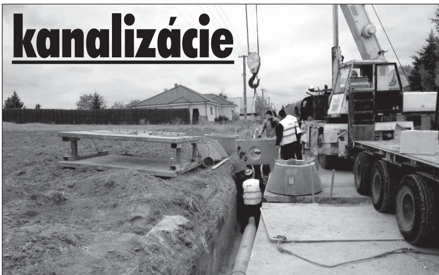
● Montáž šachty a hlavného potrubia kanalizácie na ulici Odblavky
