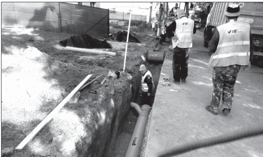
● Práce na dokončovaní rozostavanej vetvy SO 01 Stoka D2 – 2. časť v dĺžke 376 m
