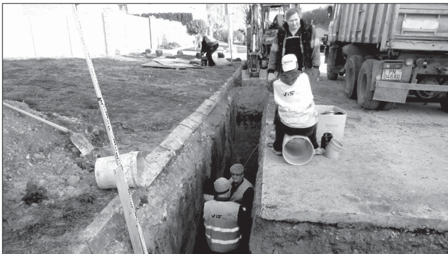
• Pracovníci firmy VIS Piešťany si pripravujú materiál na montáž hlavného potrubia a domovej prípojky kanalizácie
