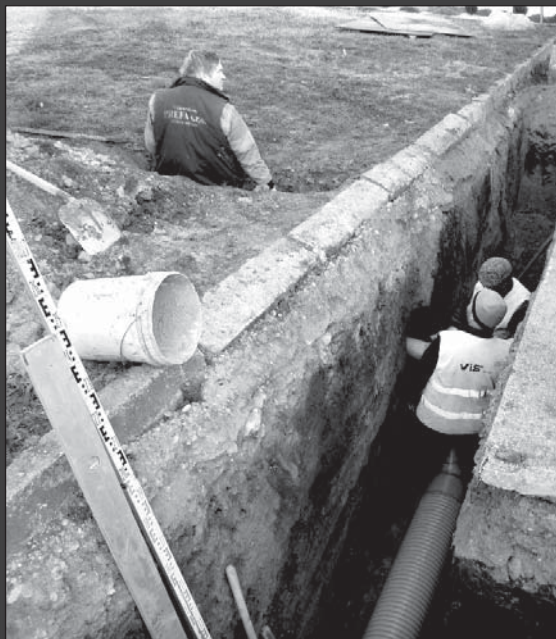
● Kanalizačná vetva D2 bola dokončená zo zdrojov obce
